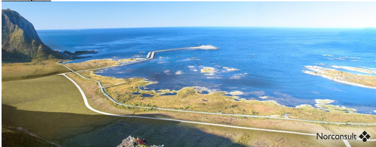
Bilde 4-1. Oversikt, sett fra fjellet. Viser molo og nytt veisystem.
