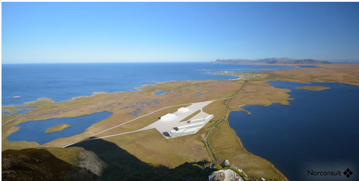
Bilde 4-6. Viser det nye service- og administrasjonsområdet sett fra fjellet. I bakgrunnen skimtes Nordmela.
