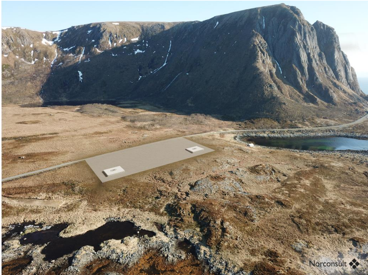
Bilde 5-1. Fase 1, interim launch pad i utvidelse av eksisterende utskytningspunkt. Tilrettelagt med kjøreareal og betongplate for utskytningsstol og grop.
