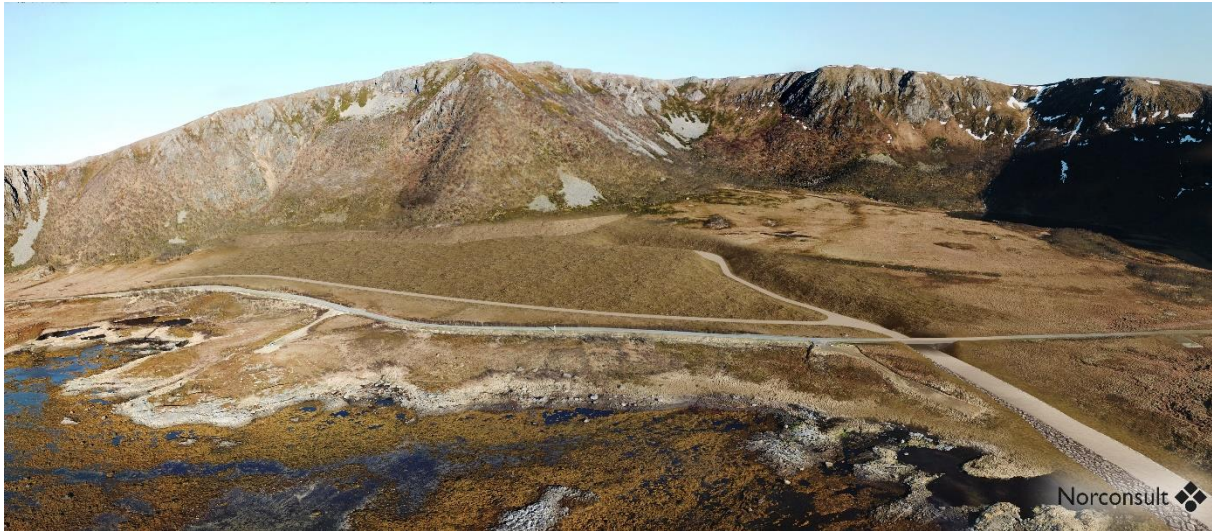
Bilde 4-4. Viser masseuttaket etter tilbakefylling, kulvert under veg, nytt vegsystem og rasvoll mot fjellet.
