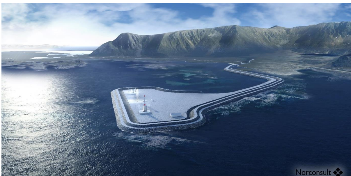
Bilde 4-3. Utskytningsrampen sett fra sjøen.
