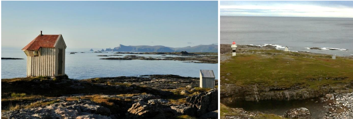
Figur 3-5. Til venstre Fyrhuset på Børhella med «oljehuset». Til høyre Børhella sett fra Bukkekjerka, med den nye fyrlykta, fyrhuset og «oljehuset» (Foto til venstre: Steinar Skaar/Statens vegvesen https://www.nasjonaleturistveger.no/ )
