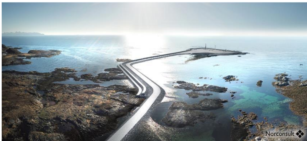
Figur 15 Oppskytningsrampe i sjø.
