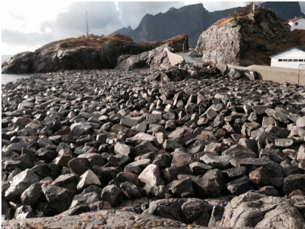
Figur 12 Eksempel på utradisjonell løsning med en lav brei skulderfylling ved Hamnøy/Reine, E10 i Lofoten
